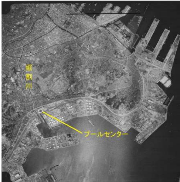
昭和 40 年頃の航空写真。根岸湾埋立地と関外地区を結ぶ堀割川。河口の左岸突堤には現在も動物検疫所がある。
