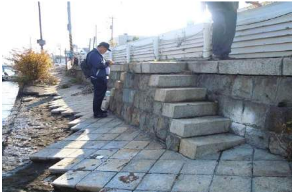
物揚げ場の階段の補修。
